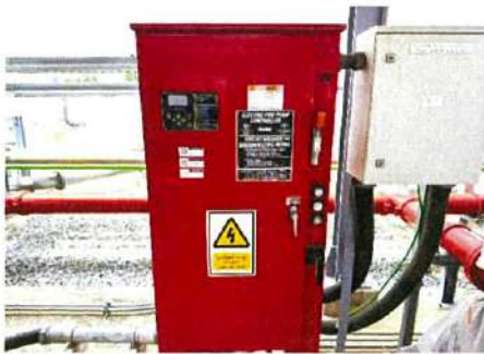
ระบบชุดควบคุมเครื่องสูบน้ำดับเพลิง (Fire pump controller system)
